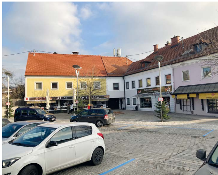
Vor Alis Kebab und auf der gegenüberliegenden Seite wurden die Parkplätze saniert.
